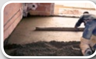
SOLERAS DE MORTERO
